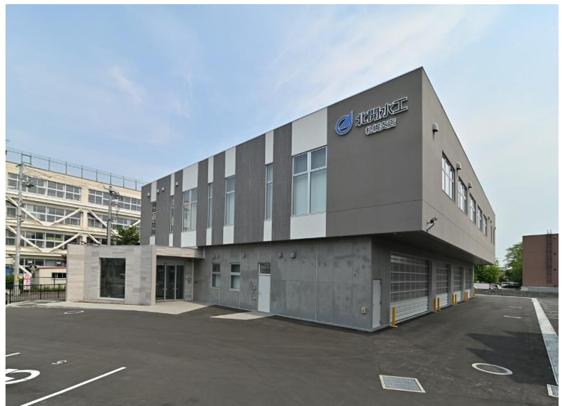
㈱北開水工コンサルタント道央事業本部札幌市支店移転新築工事 施工 岩田地崎建設㈱へ施工協力
