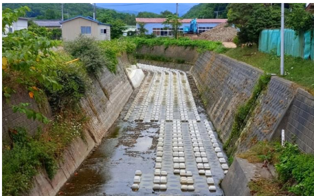
令和6年度(繰越)普通河川豊部内川河床低下防止工事
