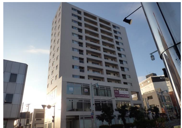
ヴィルヌーブ五稜郭 大規模修繕工事
