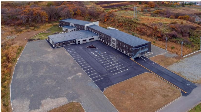
養護老人ホームひのき改築工事
