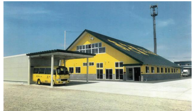
あさ陽認定こども園新築工事
