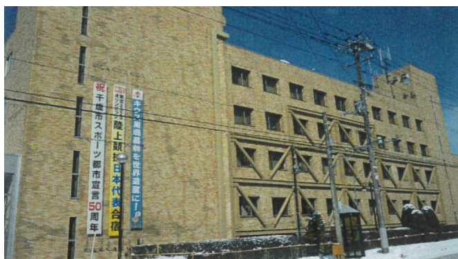
千歳市役所本庁舎耐震改修工事
