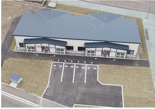
町道陣屋町7号通り道路新設工事 新陣屋団地1号棟外構工事 新陣屋団地2号棟建築主体工事
