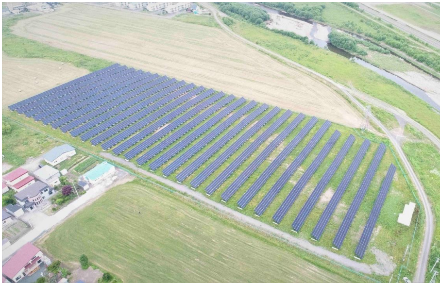
サロマ2ソーラーウエイ建設工事
