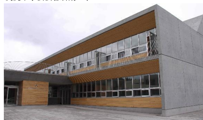
奥尻中学校校舎新築工事
