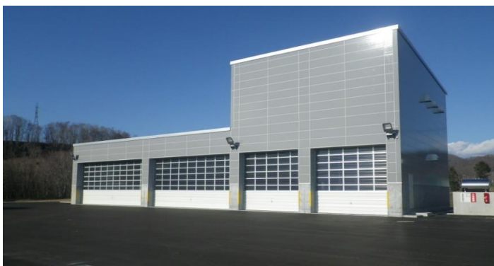
一般国道227号厚沢部町木間内除雪ステーション車庫・薬剤庫
