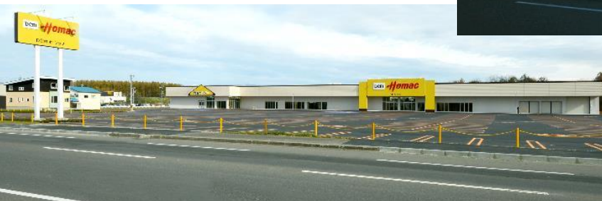
ホームマック倶知安店新築工事
