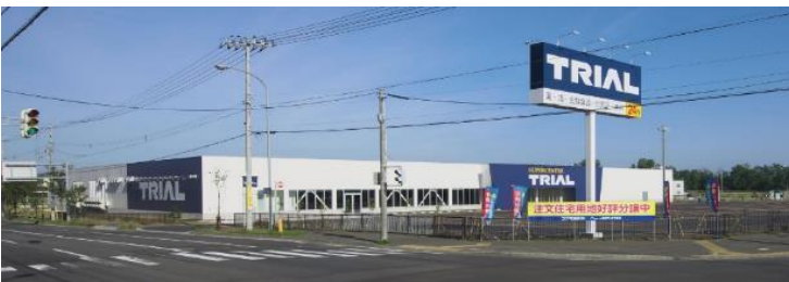
TRIAL手稲星置店新築工事(2014/09)
