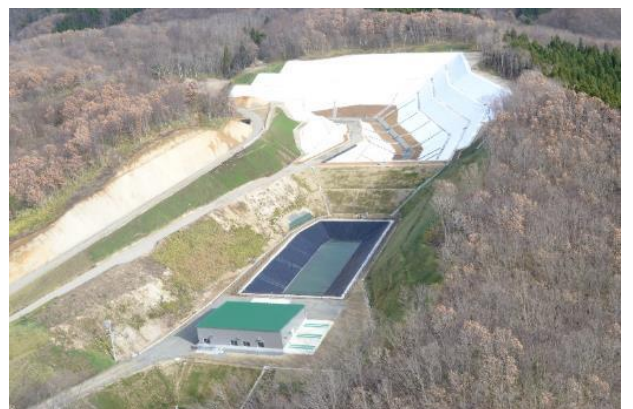
江差産業廃棄物最終処分場建設工事(2014/11)
