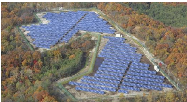
苫小牧太陽光発電所建設工事(2014/10)
