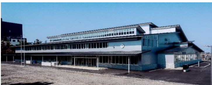
江差中学校新築工事(2014/12)
